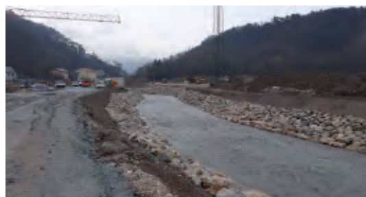
Umleitungsgerinne für die Triesting
