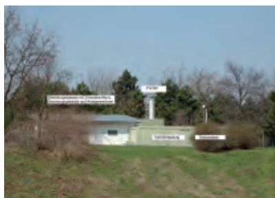
3 Betriebsgebäude der Sicherungsanlage der Altlast „Rudolf-Zeller-Gasse“
