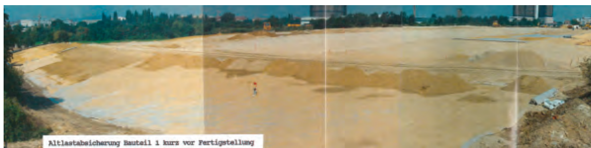
Altlastabsicherung Bauteil 1 kurz vor Fertigstellung
