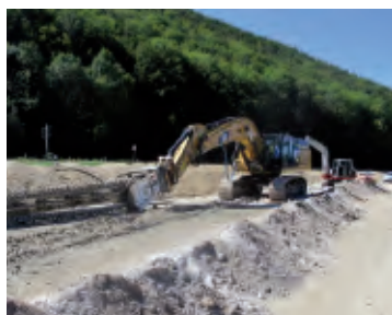
Einsatz einer Schwertfräse
