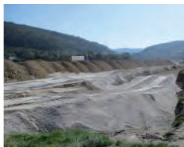
Schüttung des rechten Leitdammes
