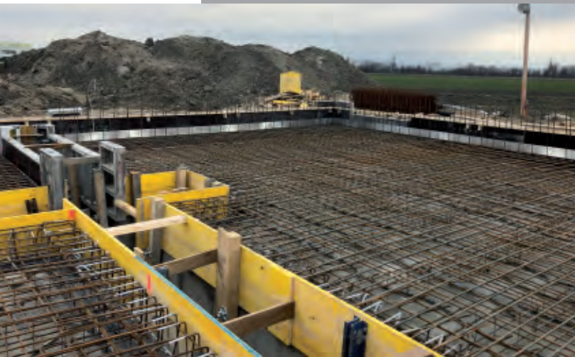
Bewehrungs- und Betonierarbeiten an der Bodenplatte des Tiefbehälters Engelhartstetten
