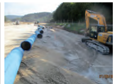
Verlegung der Wasserleitung DN500
