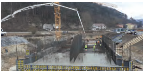
Errichtung der Bodenplatte des Grundablassbauwerkes
