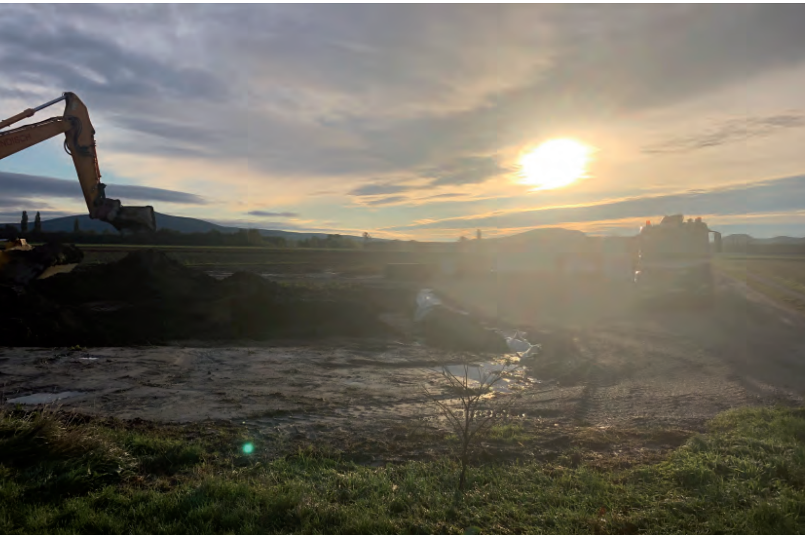
Tiefbehälter Engelhartstetten: Morgendliche Stimmung zum Beginn der Aushubarbeiten der Baugrube für den Tiefbehälter
