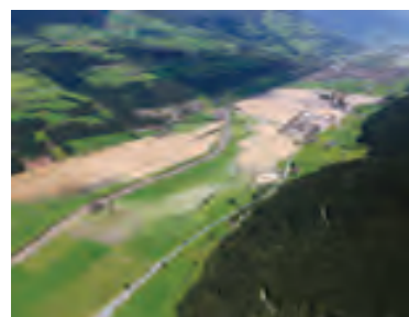
Flugaufnahme vom 19.07.2021 vom Hochwasser der Salzach im Oberpinzgau zwischen Mittersill und Hollersbach; im Hintergrund das gefüllte Hochwasserrückhaltebecken Mittersill
