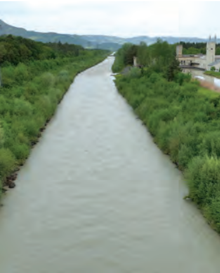
Monotoner, begradigter Zustand der Ill vor Umsetzung der gewässerökologischen Verbesserungen
