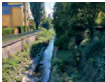
Blick von der Neilreichbrücke flussab auf die gepflasterte Sohle des Liesingbaches
